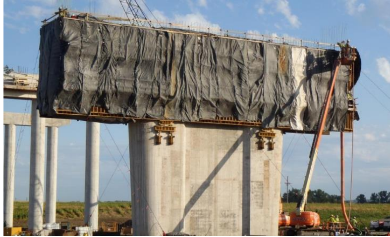
Hình 2. Dùng bạt che phủ chống sốc nhiệt khối đổ
